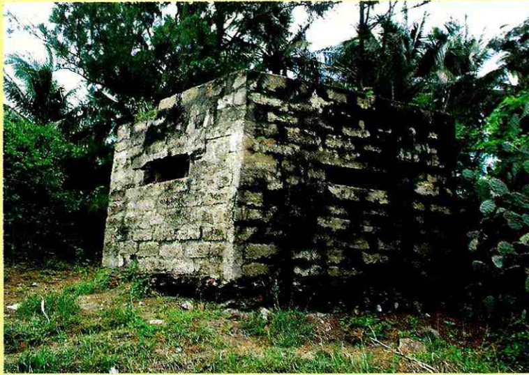
Một trong những lô cốt Pháp xây dựng tại Mũi Né.
